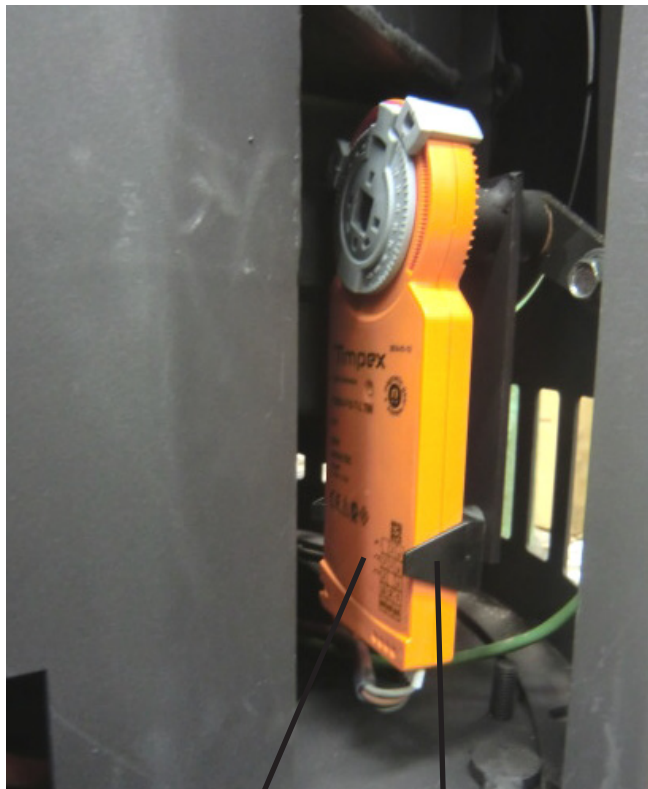
Stellmotor Kunststoff-Halteklammer
