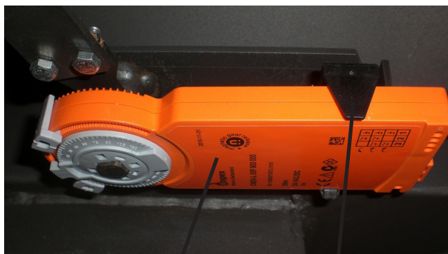
Stellmotor Kunststoff-Halteklammer
