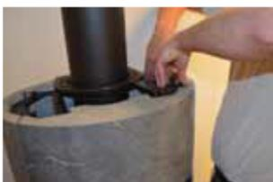
**17:** Montieren Sie nun den Stahlhalter oben ab und entfernen Sie den Seitenstein vorsichtig.
