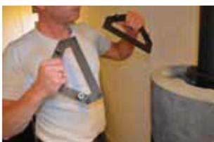
**14:** Befestigen Sie die 4 oberen Steine mithilfe der mitgelieferten Stahlhalter. Sorgen Sie dafür, dass die Stahlhalter ganz in die Löcher des Specksteins hineingedrückt werden.
