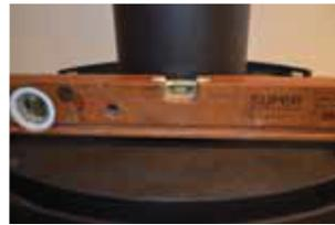
**7:** Kontrollieren Sie, dass sich der Ofen in der Waage befindet. Montieren Sie falls nötig die 4 Füße unter dem Ofen oder stellen Sie diese ein, sodass dieser stabil und sicher auf der Unterlage steht. **ACHTUNG! Es müssen mindestens 8 mm Freiraum unter dem Ofen sein, falls eine zugeschnittene TermaTech-Glasplatte montiert werden soll.**
