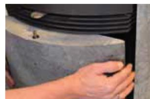
**24:** Montieren Sie den Stein vorsichtig mit der Dichtungsseite nach unten zeigend im Holzfach und drücken Sie den Zapfen an der Oberseite nach unten, sodass dieser im Loch der Lamellen einrasten kann - setzen Sie ihn vorsichtig an seinen Platz.
